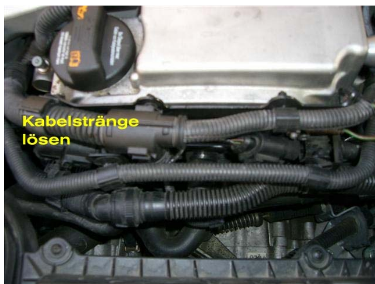
Bild: U-1.0.0_4 – Demontage der Kabelstränge
